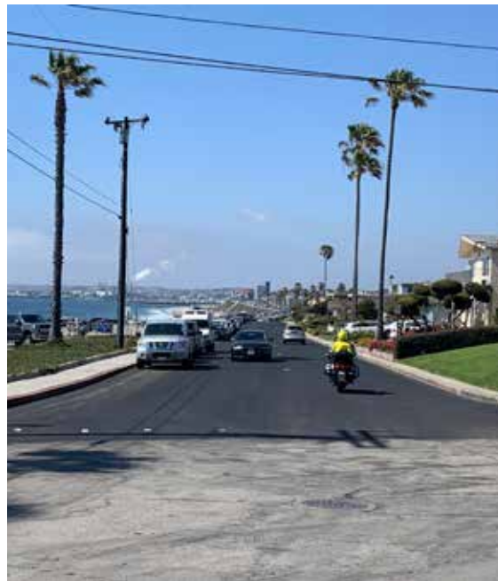
Rehab line on Paseo de La Playa
